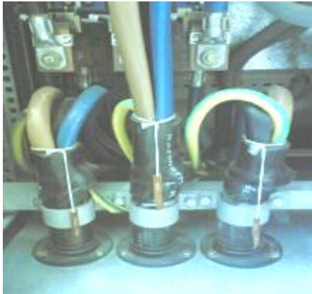
شکل 9-3 پلاک استفاده شده برای شناسایی کابل در کف تابلو
