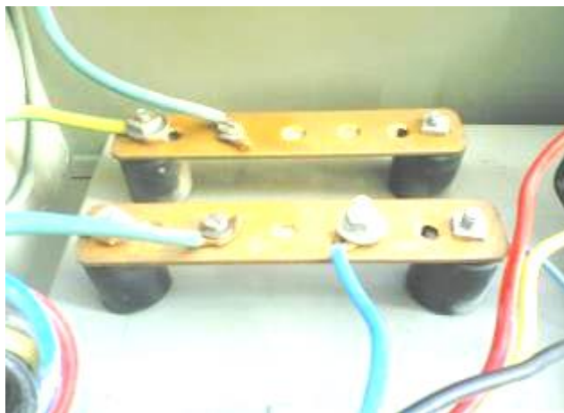
شکل 1-2 پوشینگ‌های استفاده شده در تابلو
