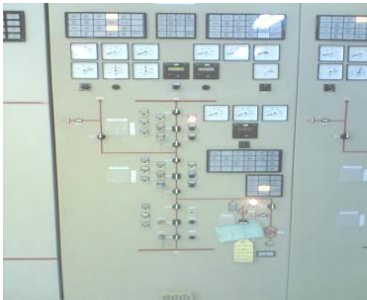
شکل 11-3 شماتیک تک خطی هر سلول تابلو فشارمتوسط
