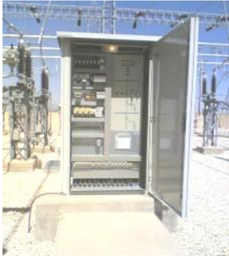
شکل 3-5 شمای کلی یک تابلو نصب در محوطه باز شکل 4-5 لاستیک آب بندی درب تابلو
