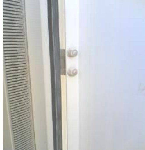
شکل 3-5 شمای کلی یک تابلو نصب در محوطه باز شکل 4-5 لاستیک آب بندی درب تابلو
