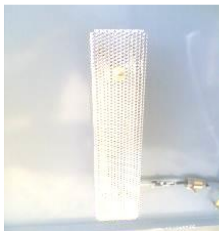
شکل 3-6 هیتر نصب شده بر روی درب تابلو شکل 3-5 لامپ ر وشنایی مورد استفاده در تابلو
