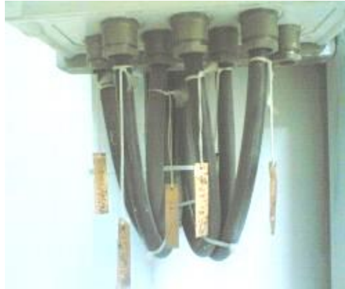
شکل 10-3 پلاکها برای شناسایی کابلها در تابلو
